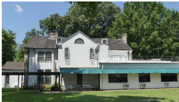
L'arrière de la maison (2006)
